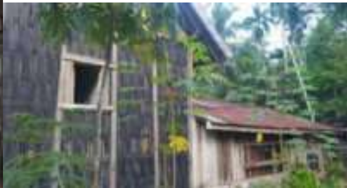
Kondisi rumah tampak samping
