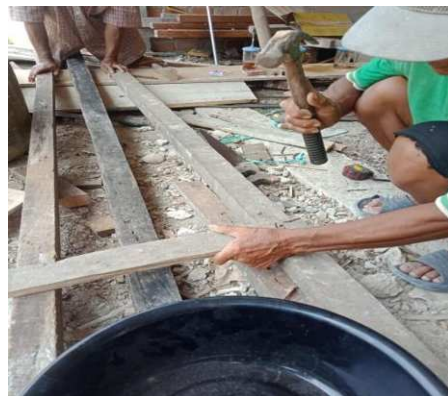
Pemasangan penyangga tray
