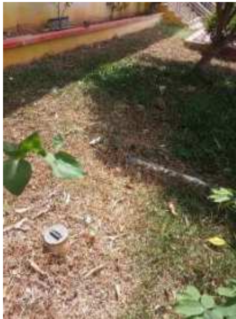
Aliran septic tank kurang memadai dan tidak tertutup
