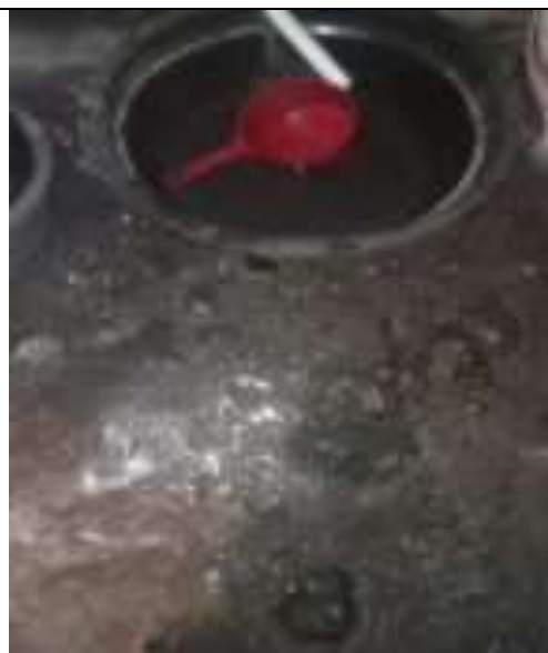
Kondisi lantai jamban yang tidak kedap air karna retak retak
