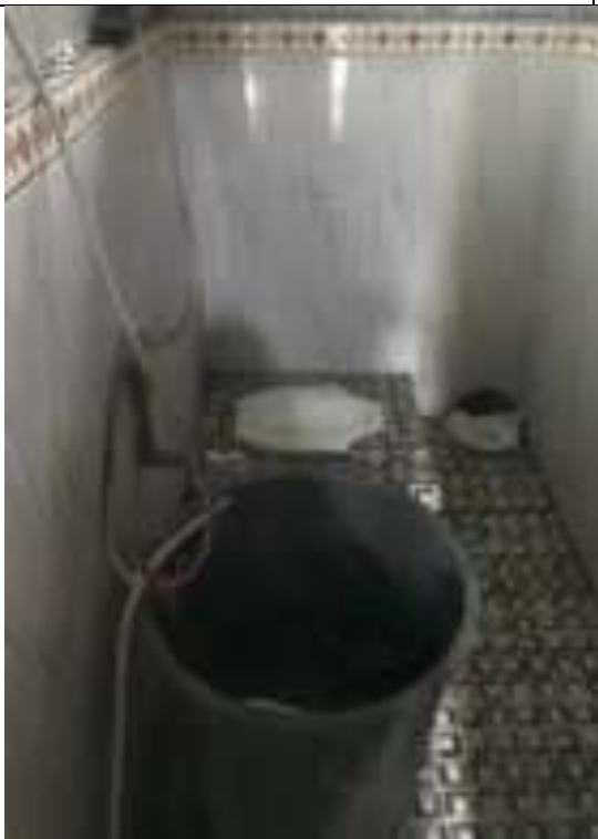
Kondisi Kedudukan Jamban mempunyaikloset tetapi tidak mempunyai septik tank
