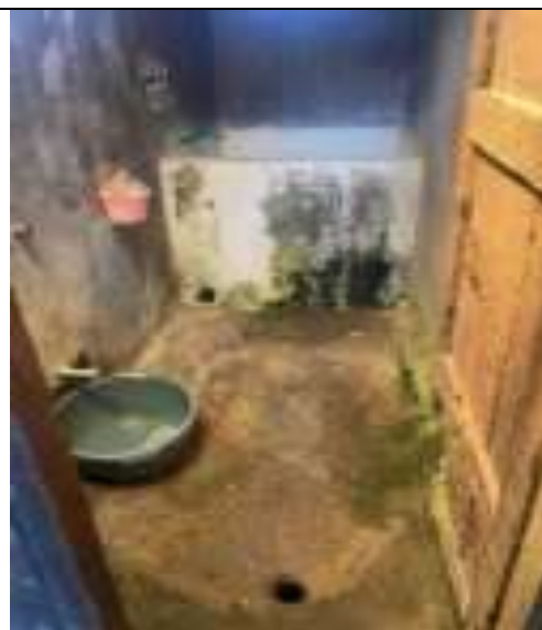
Kondisi kedudukan jamban tidak mempunyai kloset dan tidak mempunyai septik tank
