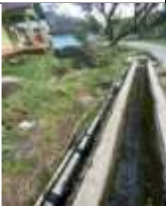
Air yang di alirkan terlebih dahulu melalui pipa paralon ukuran besar kemudian di distribusikan ke rumah rumah warga melalui cabang pipa yang lebih kecil
