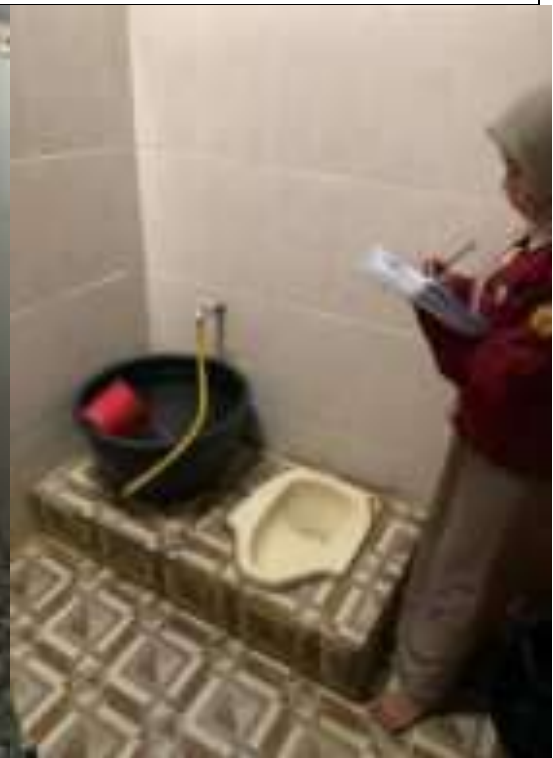
Kondisi jamban terdapat air pengelontor di kloset untuk mencegah serangga masuk
