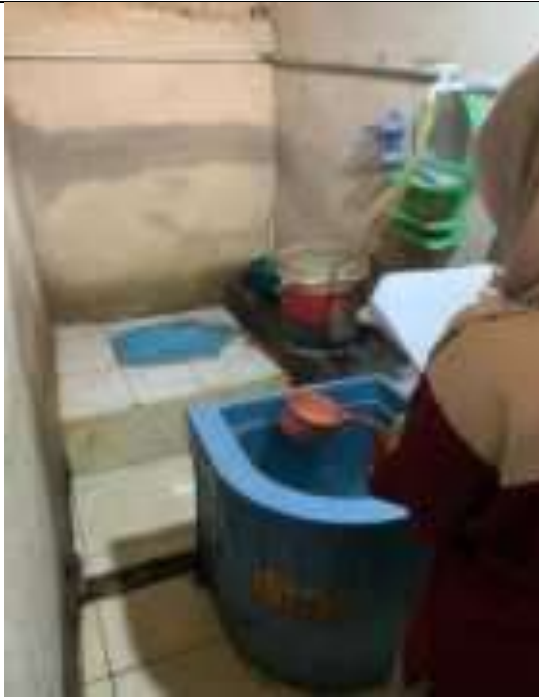
Kondisi lantai jamban yang licin karna kramik licin
