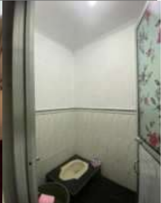
Kondisi jamban yang tidak memiliki ventilasi
