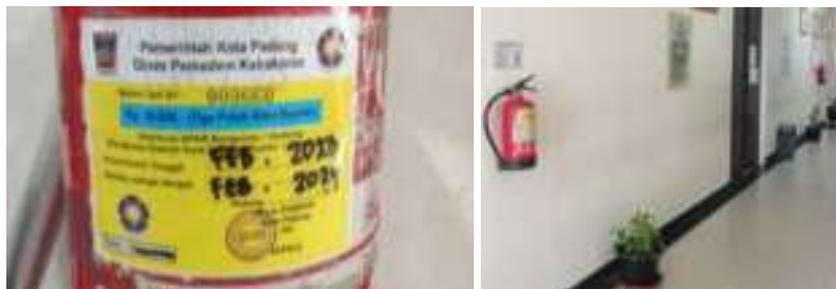
**Gambar 13. Kondisi dan Penempatan APAR pada Gedung**
