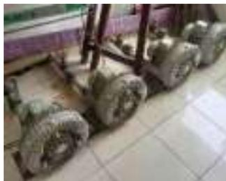
**Gambar 29. Blower Yang Mensuplai Udara Ke Dalam Bak Aerasi**
