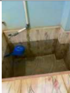
Bak penampung air yang jarang dibersihkan
