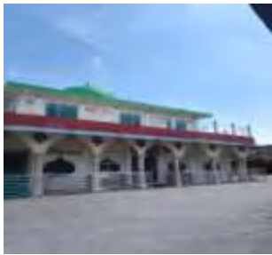
Kondisi bangunan Masjid Al Mujahadah
