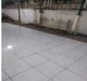
Kondisi lantai Masjid Tasyakkur
