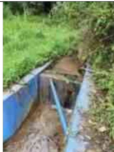
Saluran penangkap air yang berlumut dan endapan lumpur
