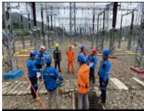
Briefing Sebelum Bekerja Pada Gardu Induk
