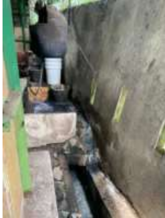
Kondisi Saluran Air Limbah
