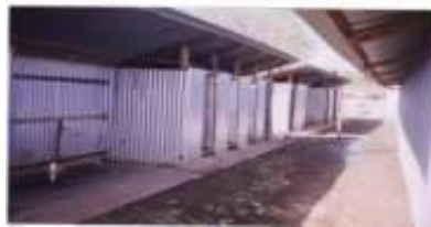
Gambar 2.5 : Jamban Yang Dibangun Setelah Masa Awal Kejadian Bencana
