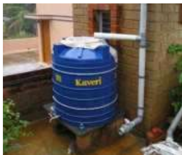
Gambar 2.2 : Penampungan Air Hujan Sumber : penampungan-air-hujan
