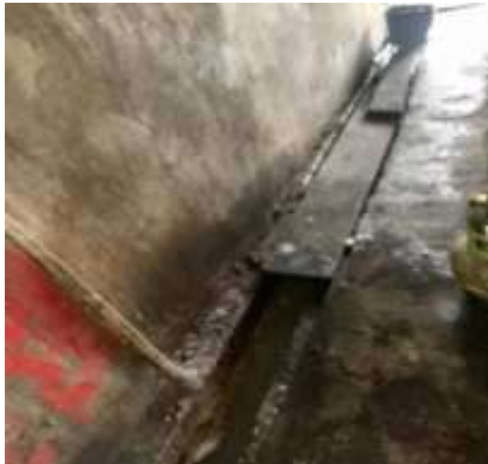
Gambar 5 Mahasiswa melihat Fasilitas Sanitasi (Saluran Air Limbah) Rumah Makan
