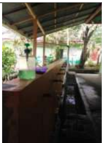
Fasilitas cuci tangan di dekat toilet
