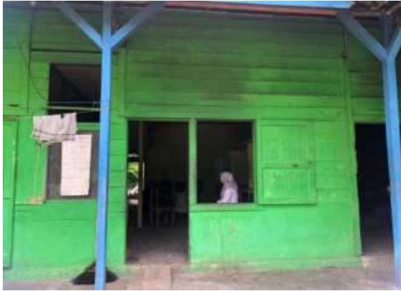
Tempat pengolahan makanan (dapur)
