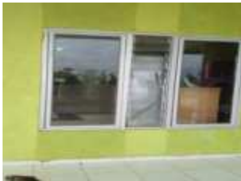
Kondisi ventilasi yang ada di asrama putra
