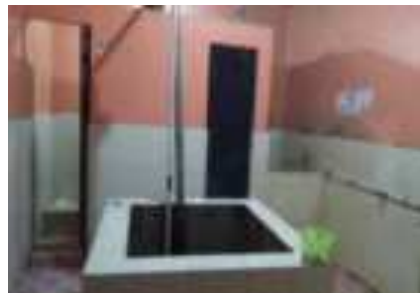
Kondisi jamban dan kamar mandi asrama putri
