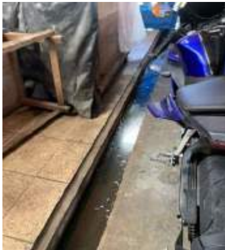
Saluran pembuangan air limbah di los ikan yang tidak mengalir dengan lancar
