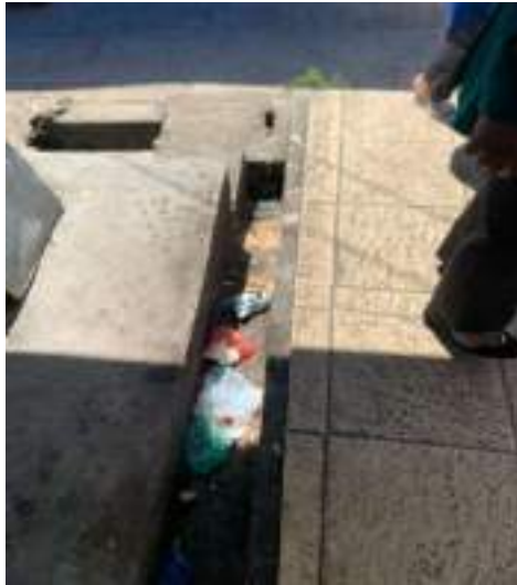
Sampah yang berserakan di dalam saluran pembuangan air limbah
