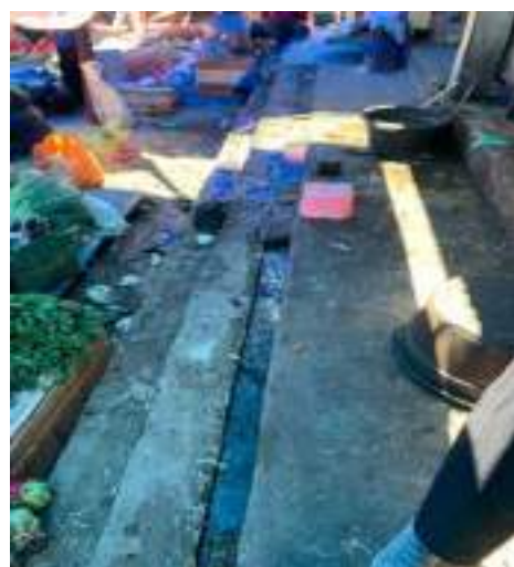
Saluran pembuangan air limbah di los ayam yang tidak mengalir dengan lancar
