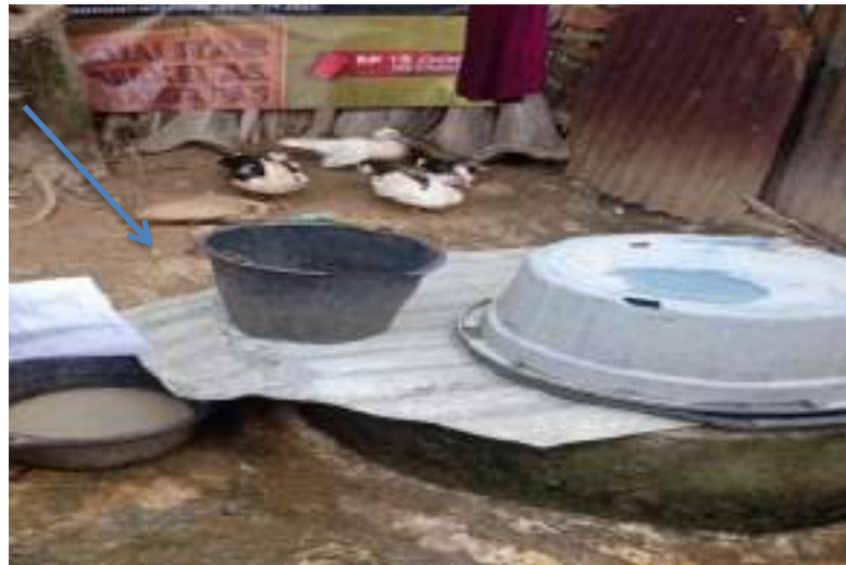
Gambar 4.5 Kondisi sumur gali terdapat konstruksi sumur yang tidak dilantai semen
