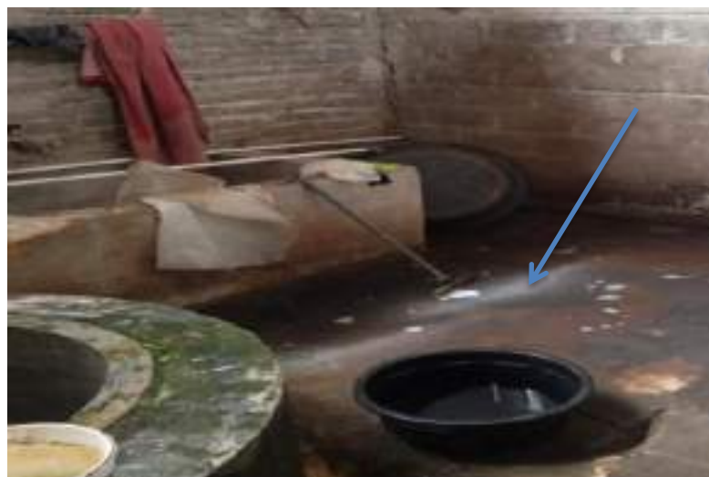
Gambar 4.1 Kondisi sumur gali yang terdapat genangan air disekitar sumur gali masyarakat
