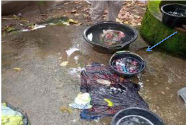
Gambar 4.6 Kondisi sumur gali terdapat konstruksi sumur dengan lantai yang retak
