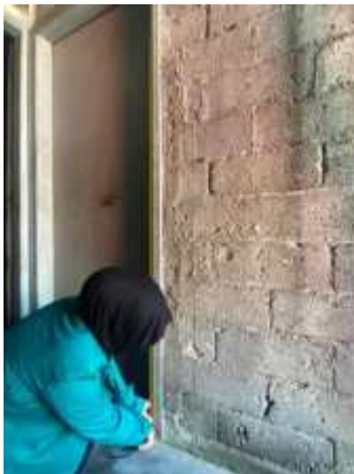
Pengukuran Ventilasi Menggunakan Meteran
