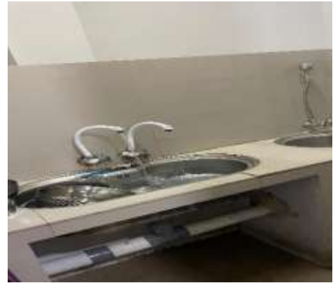
area pencucian dengan dua wastafel stainless steel yang airnya sedang mengalir, dilengkapi kran berfungsi dan sistem pembuangan di bawahnya. Namun, bagian bawah meja tampak terbuka dan kotor, serta pipa saluran air tidak tertutup, yang dapat menjadi sumber kontaminasi atau tempat bersarang hama
