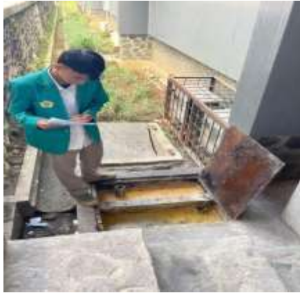
grease trap (penangkap lemak) atau saluran kontrol limbah cair tutup berkarat dan Tidak terlihat sistem pemisah limbah serta penumpukan lemak dan kotoran
